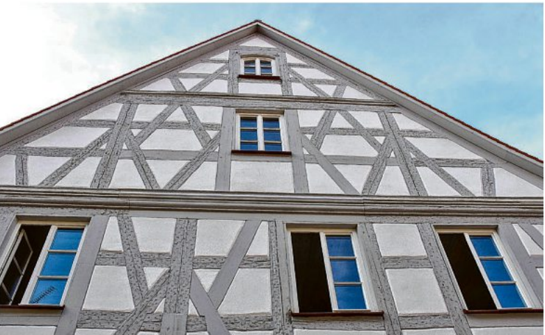
Das Einzeldenkmal „Zum Taubenbrünnlein 5“ ist saniert.
